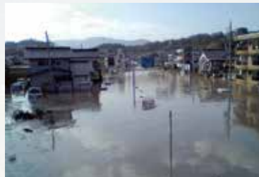
台風23号で冠水したS地区
