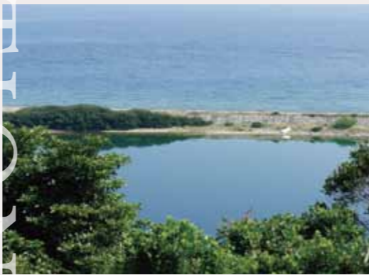
地形の理解が不十分なために行われてしまった工事の例 鹿兒島県島島では礫州が破壊されて箇所がコンクリートで固められている(2016年9月11日撮影)
